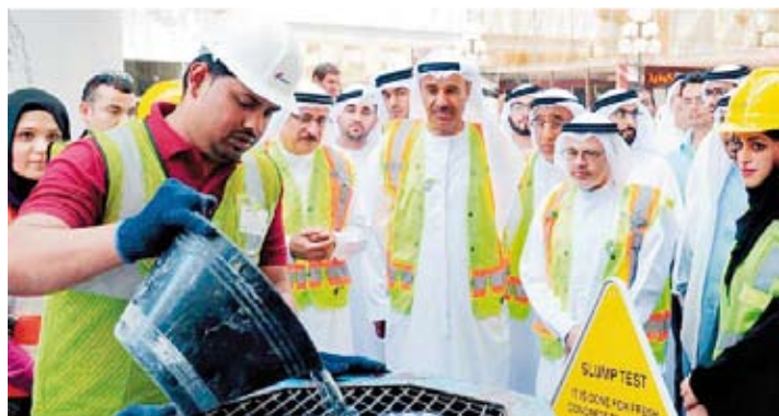
Hussain Nasser Lootah y otros funcionarios durante el proceso de mezcla de hormigón verde en Dubai llevado a cabo por Cemex. E.C.
