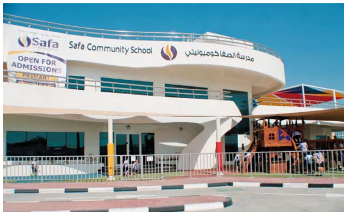
El edificio de Safa Community School presenta un novedoso estilo arquitectónico. FOTOS: EL CORREO
